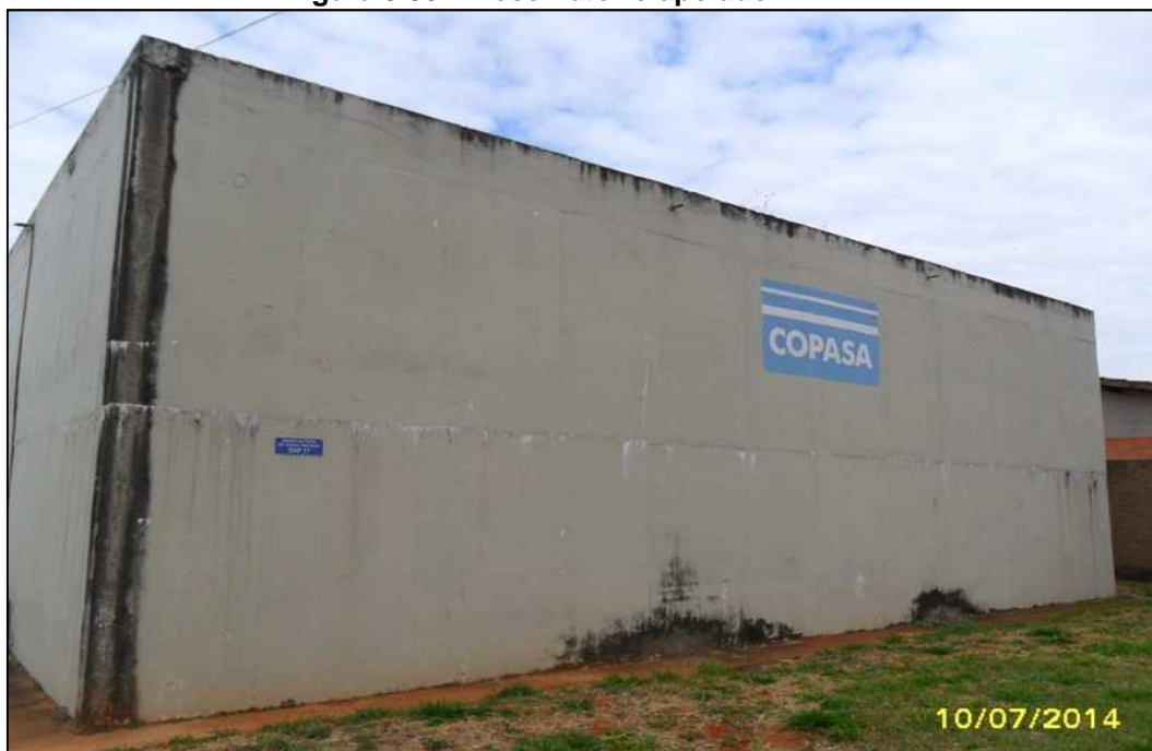
Figura 3.38 – Reservatório apoiado RAP 17.
