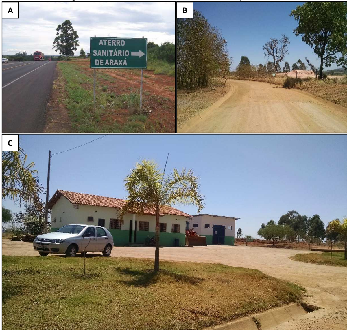
Figura 3.73 – Entrada do aterro sanitário municipal de Araxá.
