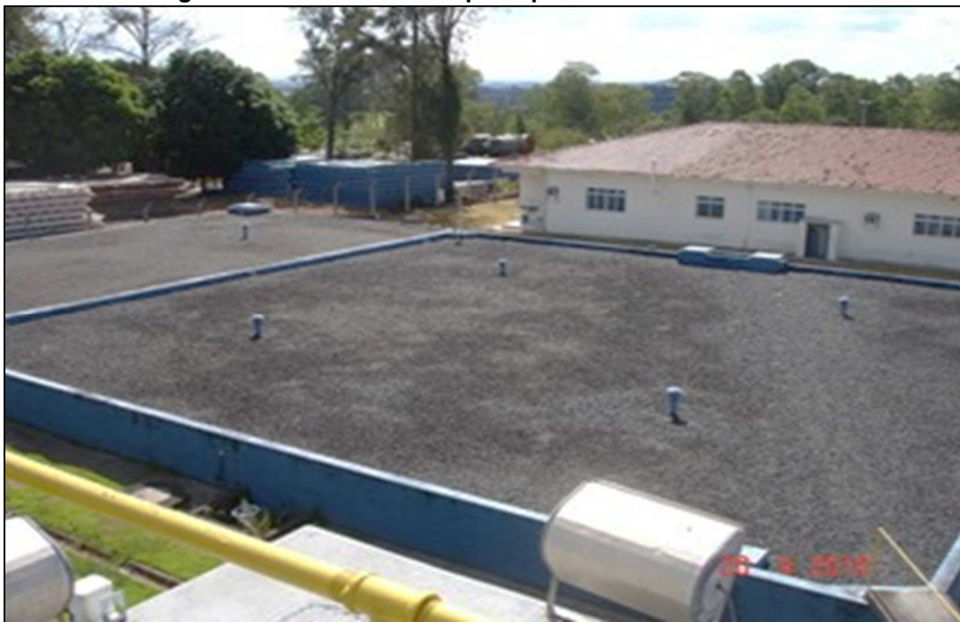
Figura 3.33 – Reservatório principal na sede da COPASA.
