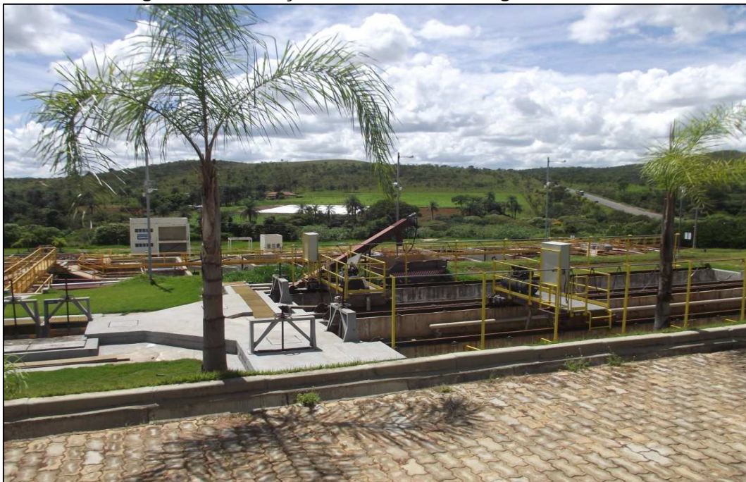
Figura 3.43 – Estação de tratamento de esgoto de Araxá.
