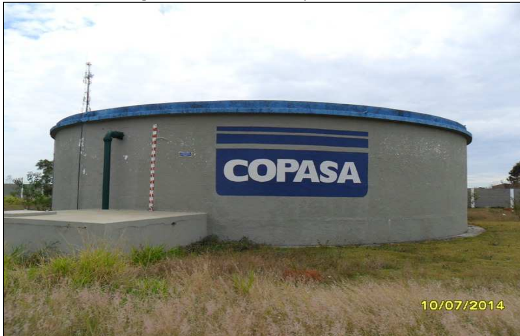
Figura 3.39 – Reservatório apoiado RAP 08.
