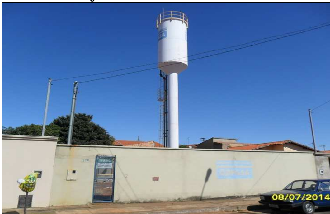
Figura 3.37 – Reservatório elevado REL 22.
