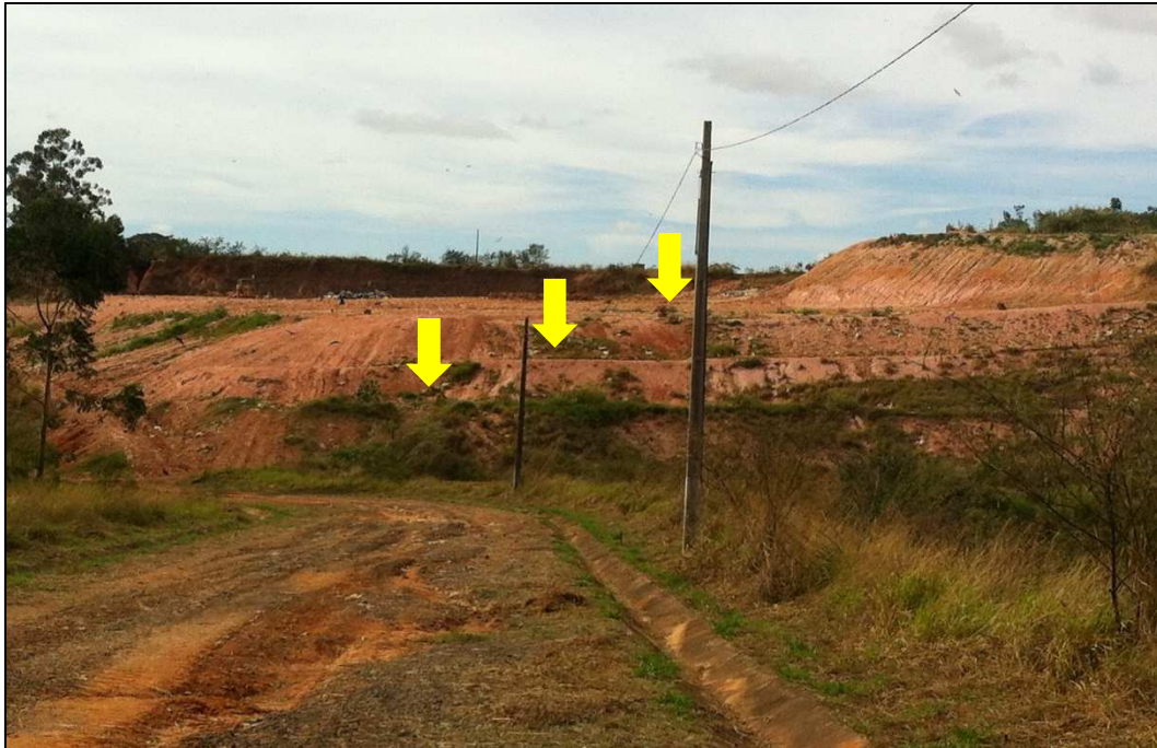
Figura 3.77 – Plataformas do aterro sanitário.
