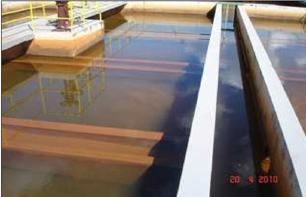
Figura 3.29 – Filtros da ETA.
