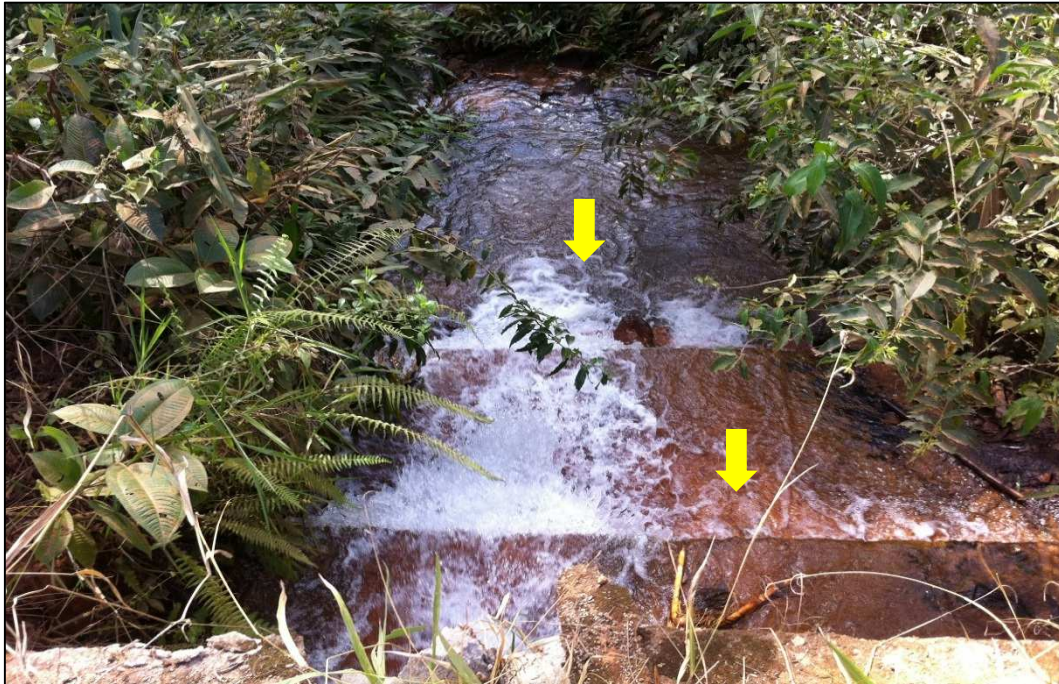
Figura 3.60 – Ponto de lançamento de água pluvial de Araxá.
